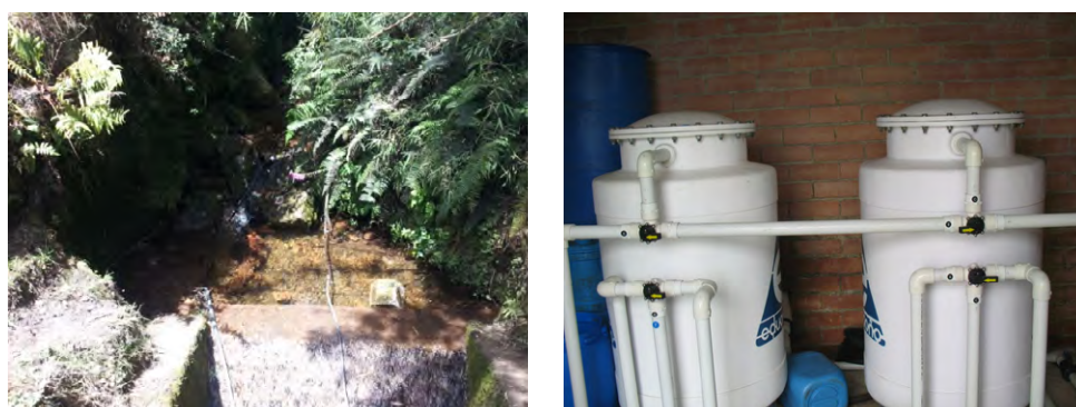
Figura 2.18. Bocatoma y planta de tratamiento Acueducto Aguas Cristalinas Los Soches ESP.
