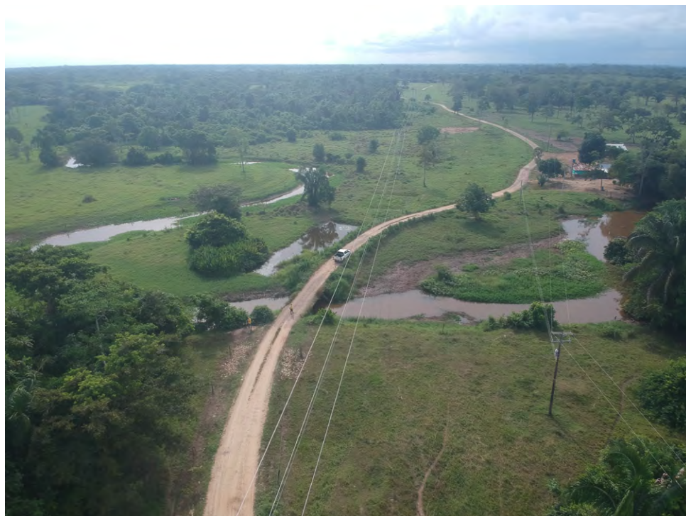
Figura 14. Carretera reciente construida por la compañía petrolera a cargo del Contrato Cravo Norte que atraviesa los esteros del Lipa. La carretera sigue el trazado del oleoducto entre los campos Caricare y Caño Limón (veredas El Progreso y Mata Oscura, Arauquita).
